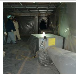
隔離養生区画内(除去作業前)
